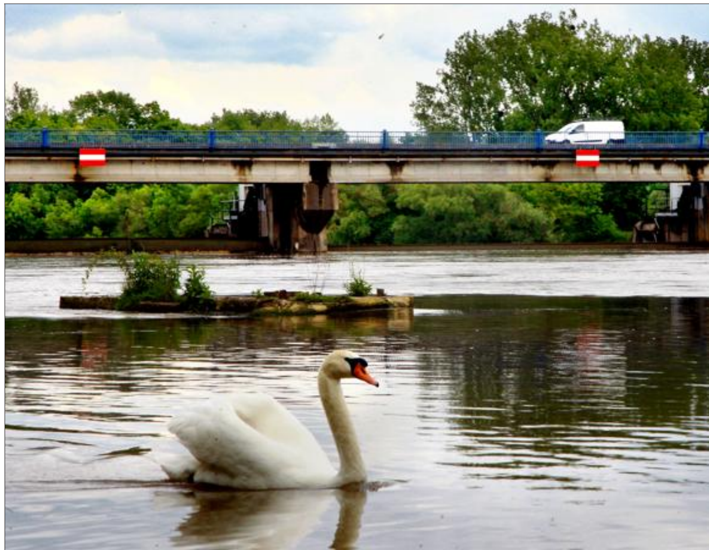
Le pont reliant Ars-sur-Moselle et Jouy-aux-Arches voit passer près de 14 000 véhicules par jour. Photo Karim SIARI
